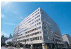
札幌市中央区北4条西6丁目の毎日札幌会館ビル6階に開設。ロビー、会議室、研究調査室、講義室2室を設置。
